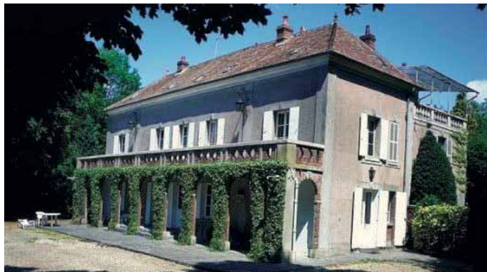
Grande maison de maître du second empire, dite château de la Garenne.
