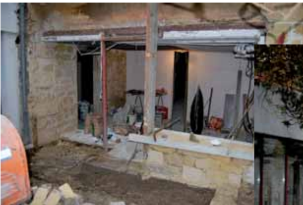
.... avant et après travaux
