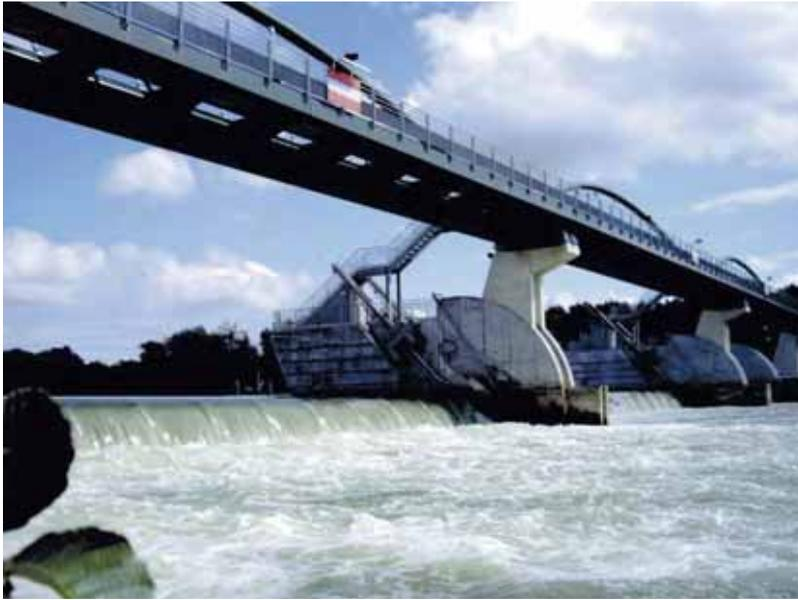
◀ Le superbe barrage d'amont, automatisé à clapets, a remplacé en 2007 le barrage Derôme de 1902. (Photo CL).
