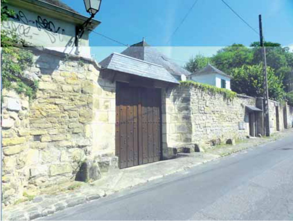
Continuité de hauts murs en pierre, portail intégré, constructions en retrait (Auvers)
