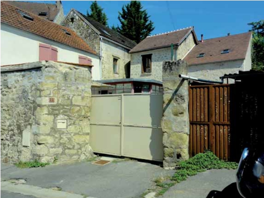
Portails inadaptés aux hauteurs de piliers
